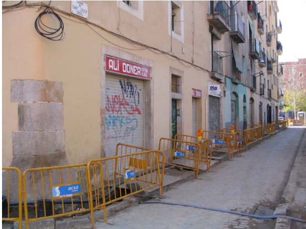
FOTO 1. Vista general de l'obra al carrer St. Josep Oriol
