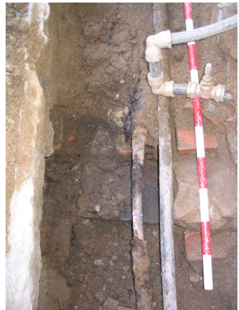
FOTO 8. UE 20 (Claveguera al carrer Espalter)
